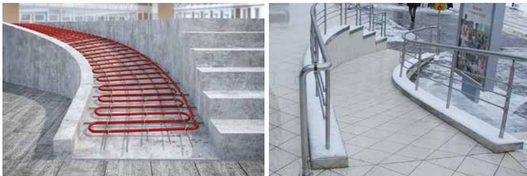
Kuva 35. KAN-therm External -pintalämmitys - asentamisen aikana ja sen jälkeen
